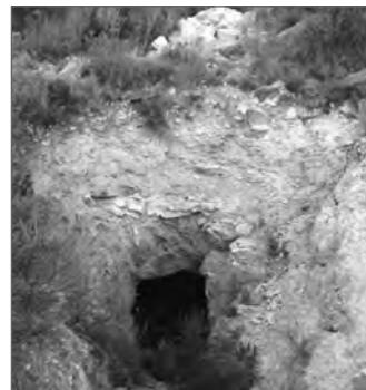
Una vez realizado el desbroce vegetal de las áreas de intervención y limpieza de los aportes de tierras tras el paso del tiempo, se pasó a reconstruir las zonas con perdidas de masa, como parte de sus bóvedas, fachadas y zonas desmanteladas por la erosión, debido a la inutilización de estos por el paso del tiempo. La técnica que se utilizó en estas construcciones fue la de la piedra en seco, colocando piedra sobre piedra sin utilizar barro, cal o argamasa, encajando una sobre otra.
